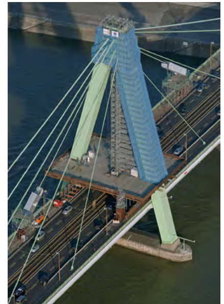
Severinsbrücke Köln, Foto: Bernhard Fischer
