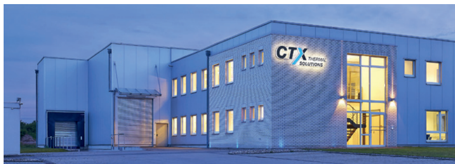
Die CTX Thermal Solutions GmbH in Nettetal
