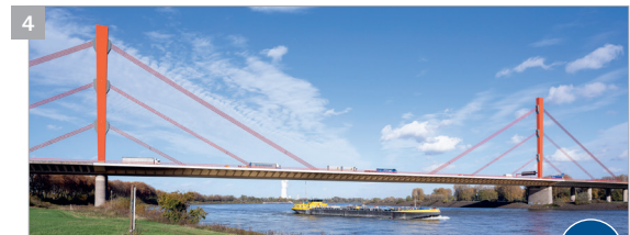
4 Beckerwerther Brücke (Baujahr 1990)
