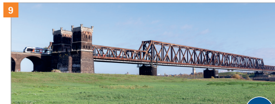
9 Duisburg-Hochfelder Eisenbahnbrücke (Baujahr 1949)
