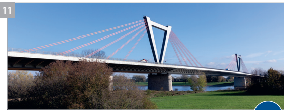
11 Flughafenbrücke (Baujahr 2002) 2,3 1 Bund 2 Autobahn 44 3 83.000 Fahrzeuge, davon 4.100 Schwerlastverkehr 4 keine
