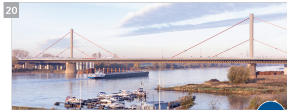
20 Rheinbrücke Leverkusen (Baujahr 1965) 1 Bund 2 Autobahn 1 3 111.900 Fahrzeuge, davon 4.476 Schwerlastverkehr 4 maximal 3,5 Tonnen 3,5
