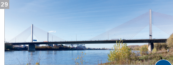
29 Friedrich-Ebert-Brücke (Baujahr 1967) 3.0 1 Bund 2 Autobahn 565 3 13.580 Fahrzeuge, davon 6.972 Schwerlastverkehr 4 Ablastung auf 44 Tonnen
