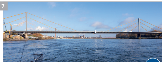
7 Rheinbrücke Neuenkamp (Baujahr 1970)
