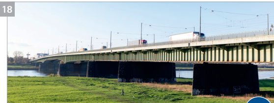
18 Josef-Kardinal-Frings-Brücke (Baujahr 1951) 1 Stadt Düsseldorf 2 Bundesstraße 1 3 57.000 Fahrzeuge, davon 3.500 Schwerlastverkehr 4 Ablastung auf 30 Tonnen 3,3
