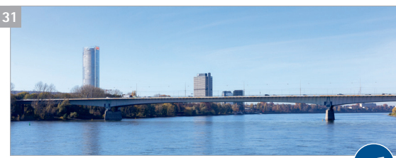
31 Konrad-Adenauer-Brücke (Baujahr 1972) 2.5 1 Bund 2 Autobahn 562 3 62.361 Fahrzeuge, davon 1.185 Schwerlastverkehr 4 keine
