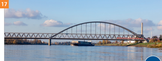
17 Hammer Eisenbahnbrücke (Baujahr 1987) 1 DB Netz AG 2 Eisenbahn 3 592 Züge 4 keine ZK2
