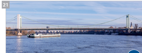
21 Mülheimer Brücke (Baujahr 1951) 1 Stadt Köln 2 Bundesstraße 51 3 konnte nicht ermittelt werden 4 maximal 3,5 Tonnen k.A.
