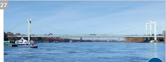
Rheinbrücke Köln-Rodenkirchen (Baujahr 1941)
