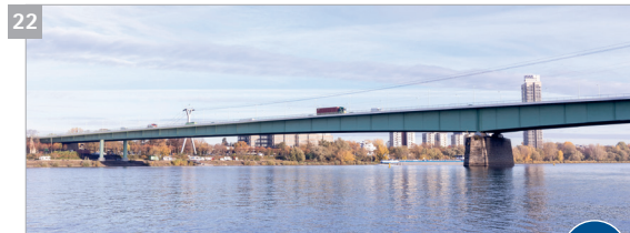
22 ZooBrücke (Baujahr 1966) 1 Stadt Köln 2 Bundesstraße 55a 3 konnte nicht ermittelt werden 4 maximal 30 Tonnen k.A.
