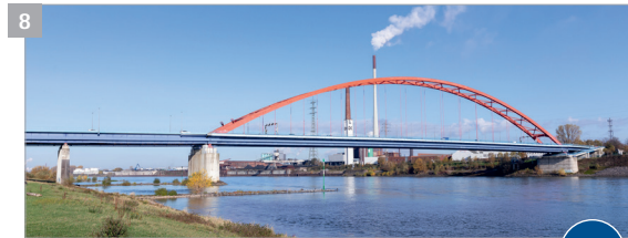
8 Brücke der Solidarität (Baujahr 1950)
