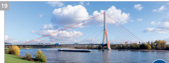
19 Fleher Brücke (Baujahr 1979) 1 Bund 2 Autobahn 46 3 85.000 Fahrzeuge, davon 12.000 Schwerlastverkehr 4 Sperrung von zwei Fahrstreifen 3,4
