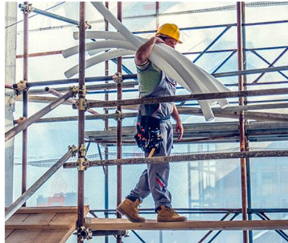
Abb.5: Umfangreiche Meldepflichten erschweren die Entsendung von Mitarbeitern ins EU-Ausland, z.B. für Montagezwecke
